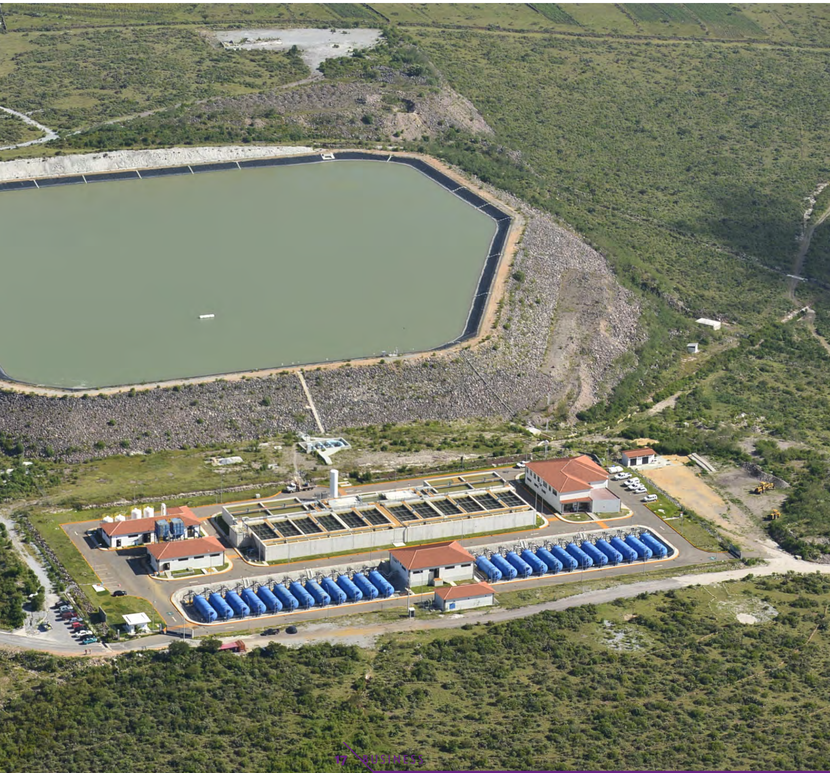
The Querétaro Aqueduct II System The San Javier WWTP (Mexico).
